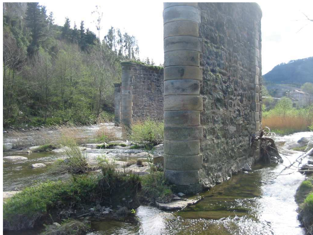
Vista General Pilas. Cimentación sobre roca
