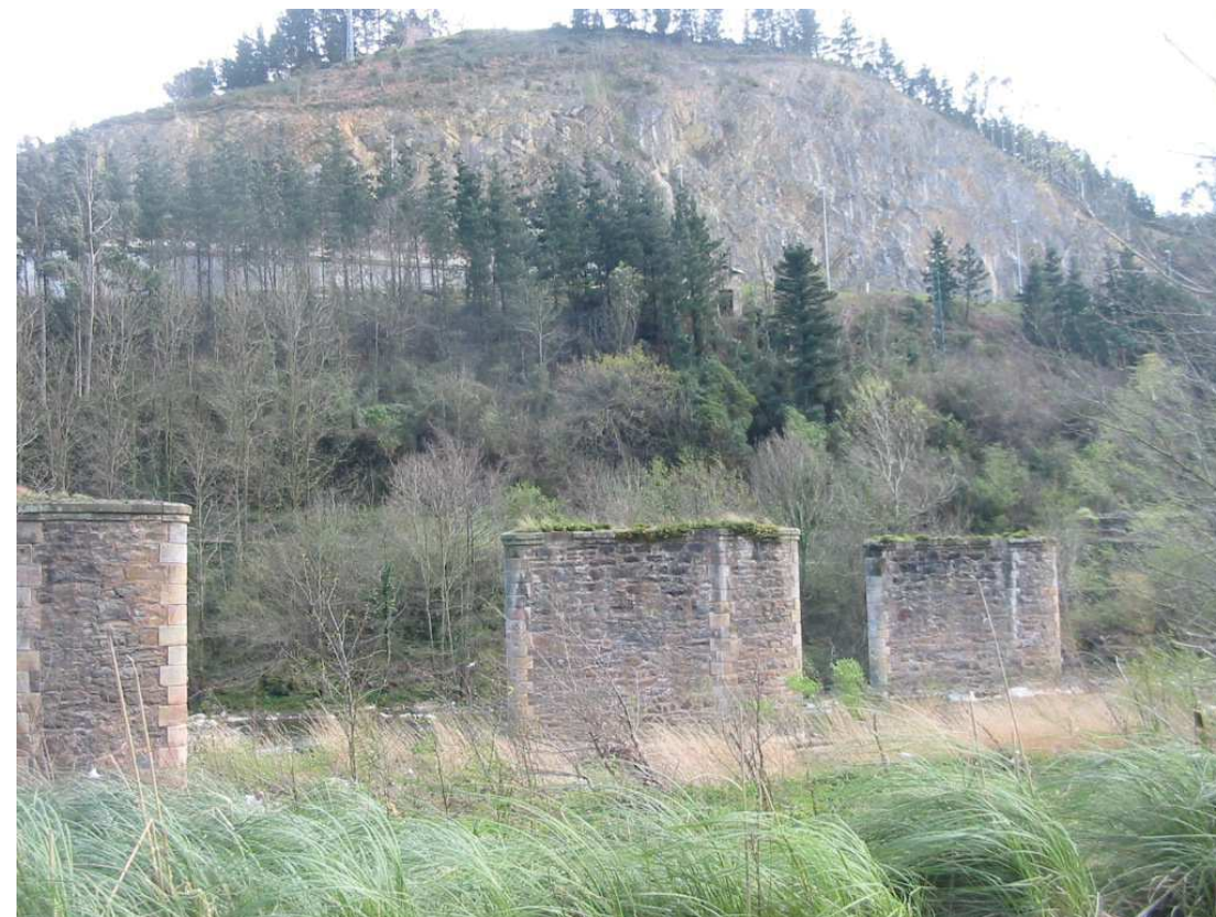
Vista General Pilas. Zona superior con vegetación
