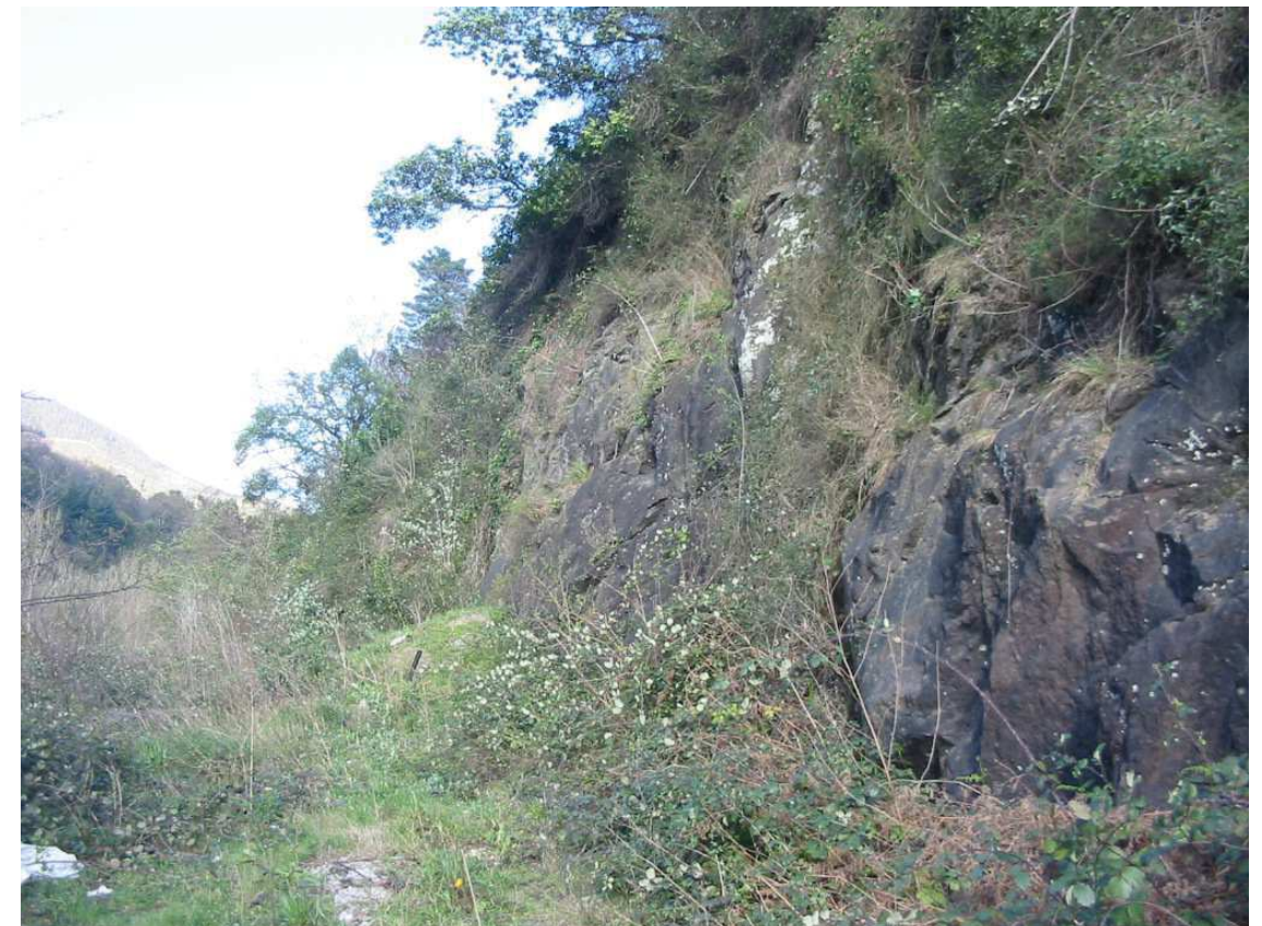
Vista Talud zona C
