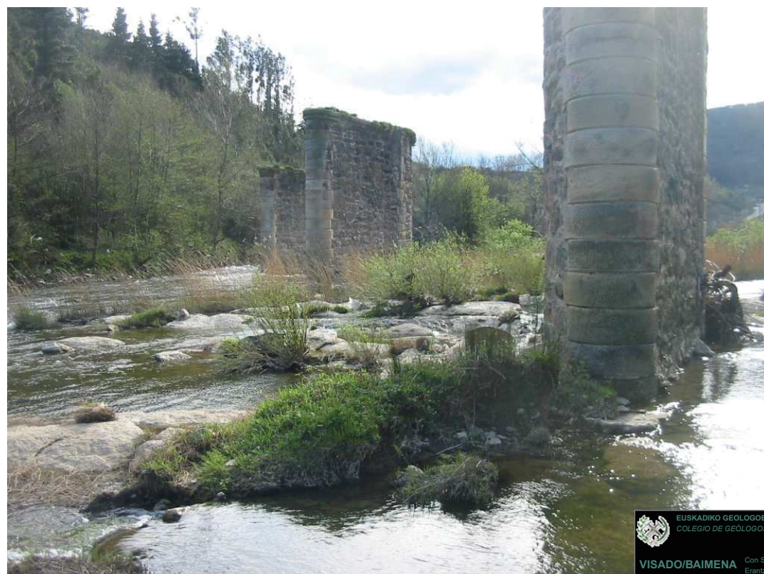
Vista General Pilas. Cimentación sobre roca
