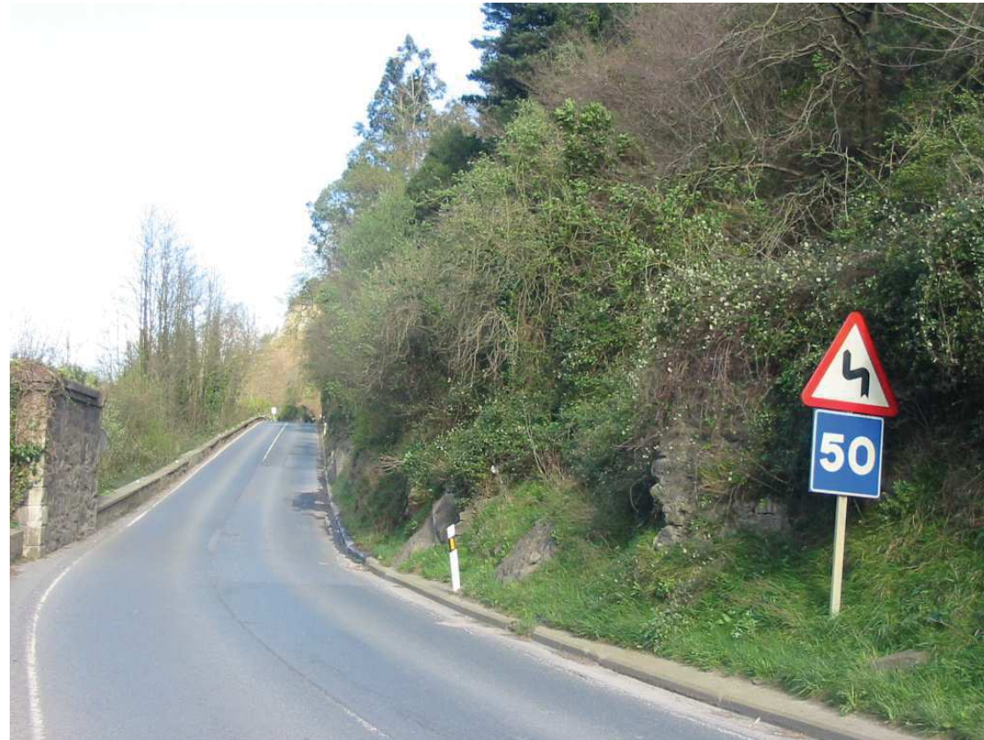
Vista General Pila 6 y Estribo Derecho
